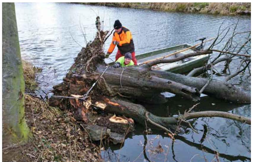
Böschungssicherung am Wurzener Kanal
